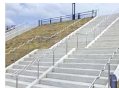
津波避難場所 長島防災高台／大分県
